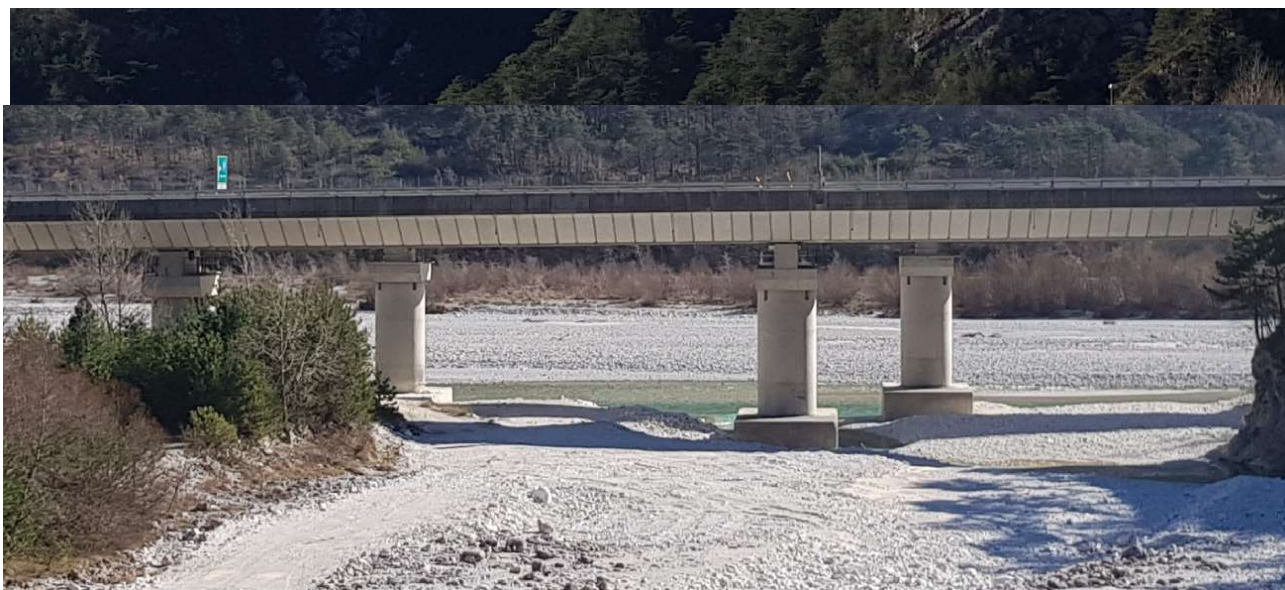
Fig. 1 - Il ponte autostradale sul rio Glagnò con la protezione spondale in pietrame recentemente realizzata sul fiume Fella
