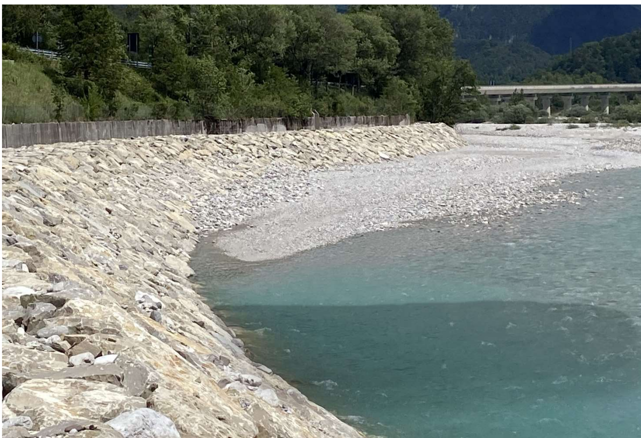
Fig. 5 - Posizione indicativa di un pennello idraulico di progetto intestato sulla scogliera (situazione di pennello completamente sotto il livello dell'acqua)
